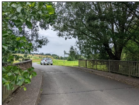
Abb. 11: Asphaltierter Feldweg mit Blick Richtung Marburger Straße (07/2024)
